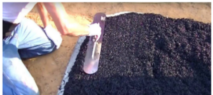
Układanie samopoziomującej warstwy DUREPOX AUTONIVELANTE na podłoża bez izolacji przeciwwilgociowej.
