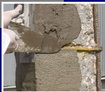
Naprawa zaprawą
